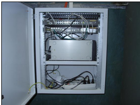
Рис. П4.3. Шкаф с сетевым оборудованием
